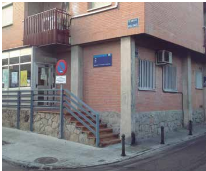
Edificio Rosa Chacel
